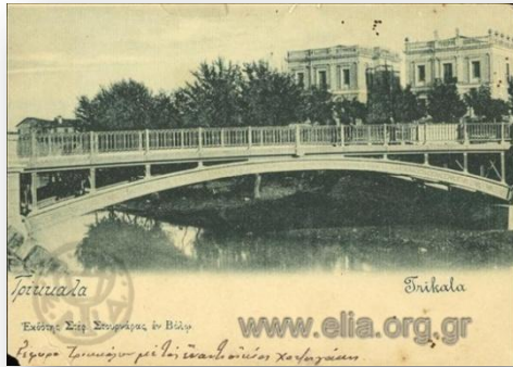
Εικόνα 13. Η Κεντρική σιδερένια γέφυρα 1904. Πηγή: http://archives.elia.org.gr8080LSeriaimages_ViewCPTHE%201.197.JPG
