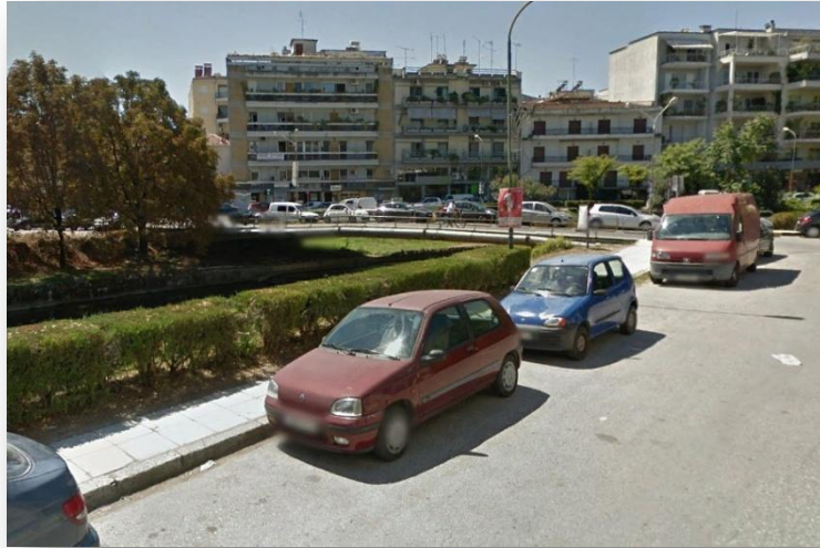
Εικόνα 31. Η νέα γέφυρα Γούρνας ή Παππά, Προσωπικό Αρχείο, 2018.
