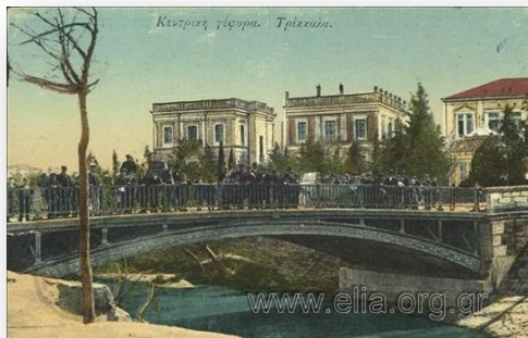
Εικόνα 15. Η Κεντρική σιδερένια γέφυρα 1922. Πηγή: http://archives.elia.org.gr8080LSeriaimages_ViewCPTHE%201.197.JPG
