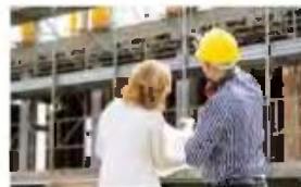
ΠΑΝΩ: Μηχανικοί εξετάζουν την πορεία κατασκευής ενός καπίου.
