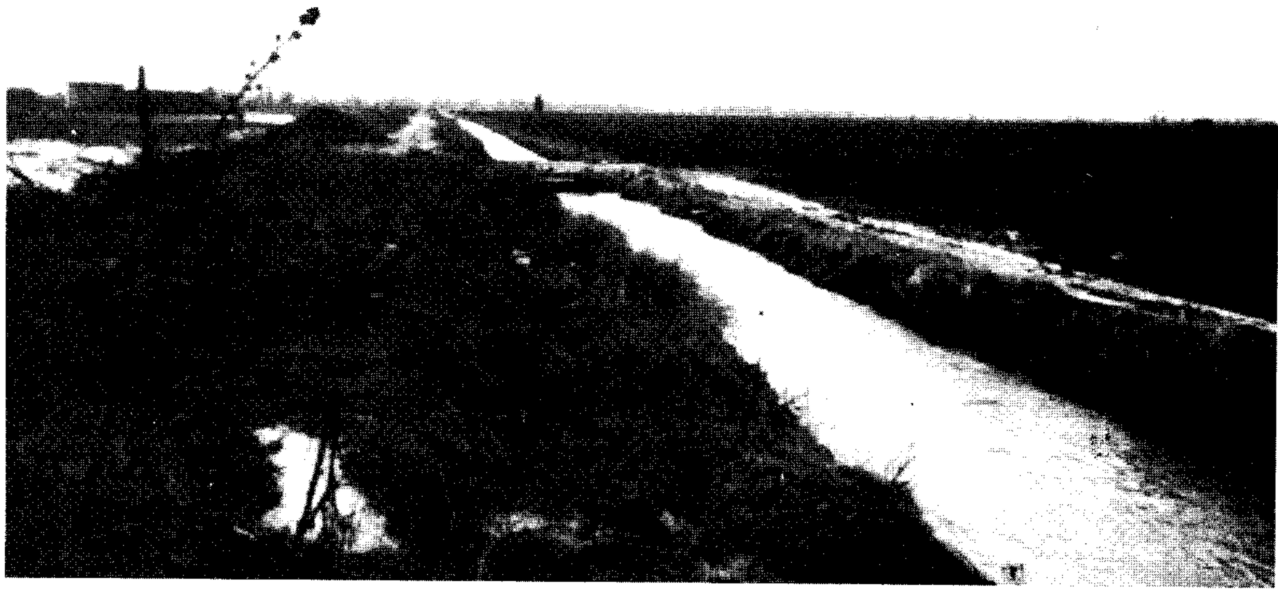
Διάβαση αγροτικής οδού πάνω από τραπεζοειδή τάφρο στο ίδιο ακριβώς σημείο της φωτ. (1). Υστερα από μελέτη κατασκευάστηκε πλακοσκεπής οχετός 3Χ2 απαραίτητος όπως αποδείχθηκε για την διοχέτευση παροχής σχεδιασμού.
